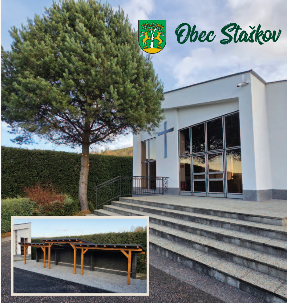
Rekonštruovaný Dom smútku s novou urnovou stenou
