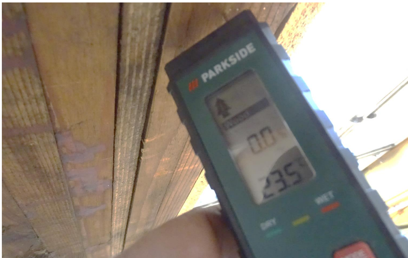
Obr. č.32 – Foto – Meranie vlhkosti pásnice stĺpa na interiéri
