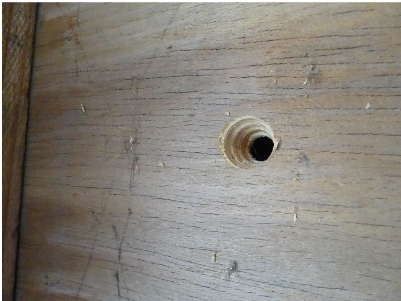
Obr. č.37 – Foto – Návrt steny pre kontrolu dutosti/výplne
