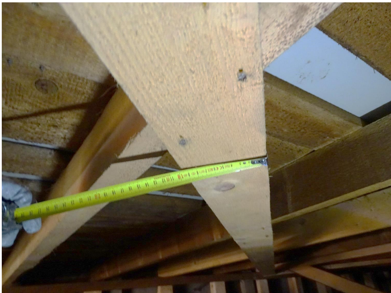
Obr. č. 15 – Foto – veterné stužidlo roviny strechy
