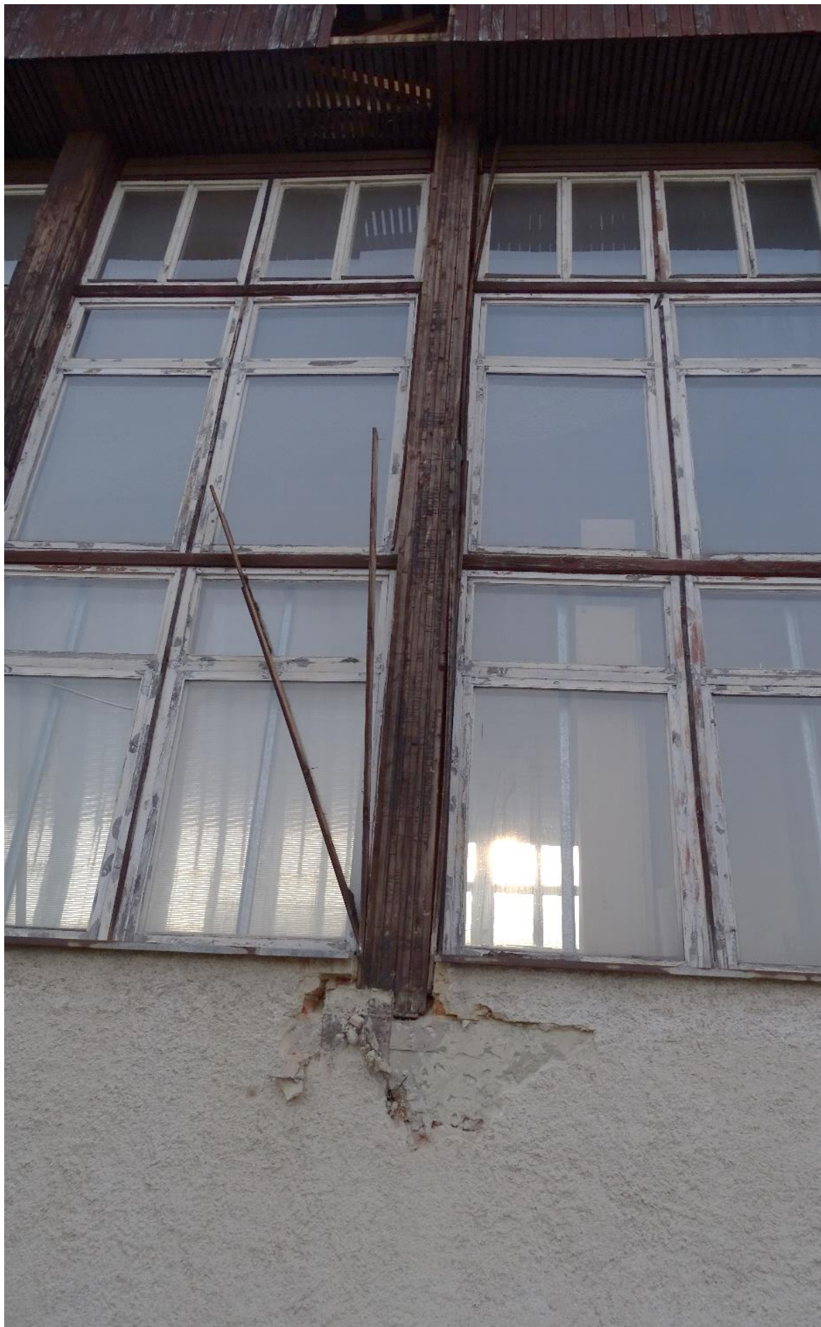
Obr. č.25 – Foto – Obnažený stĺp
