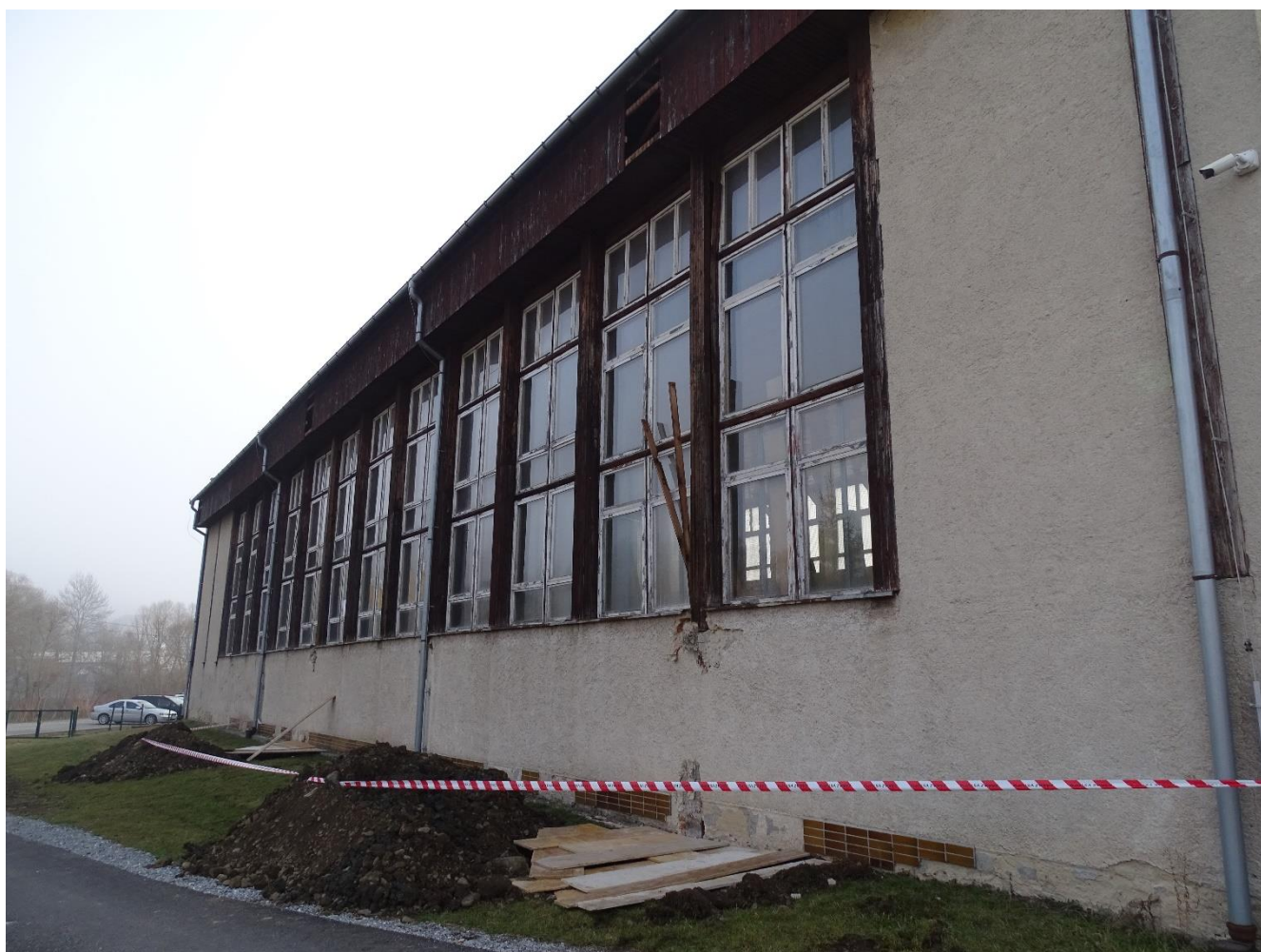
Obr. č.24 – Foto – Pohľad na obnažené konštrukcie západnej steny exteriéru
