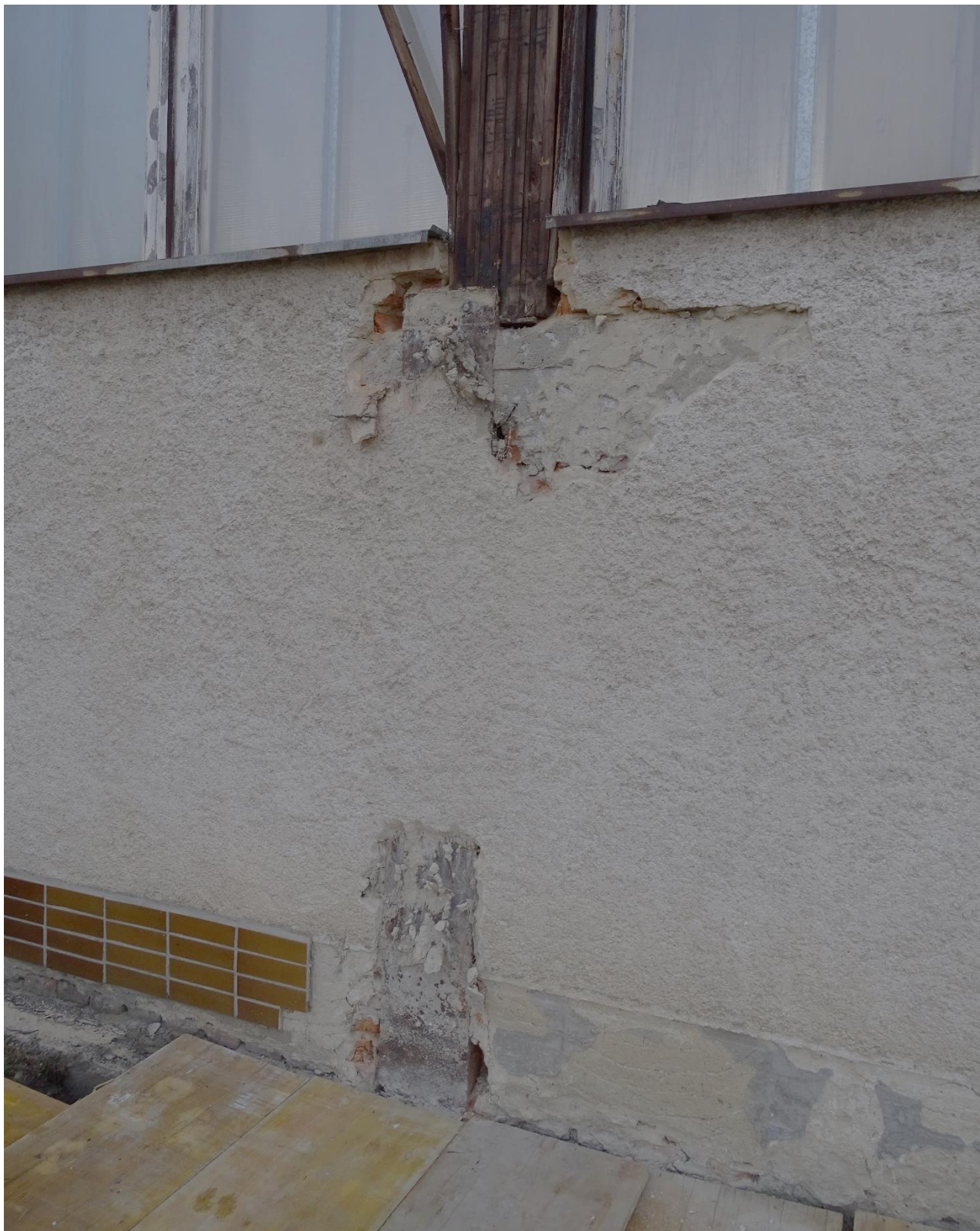
Obr. č.42 – Foto – Exteriérová časť pilierika s oceľovým U č.280
