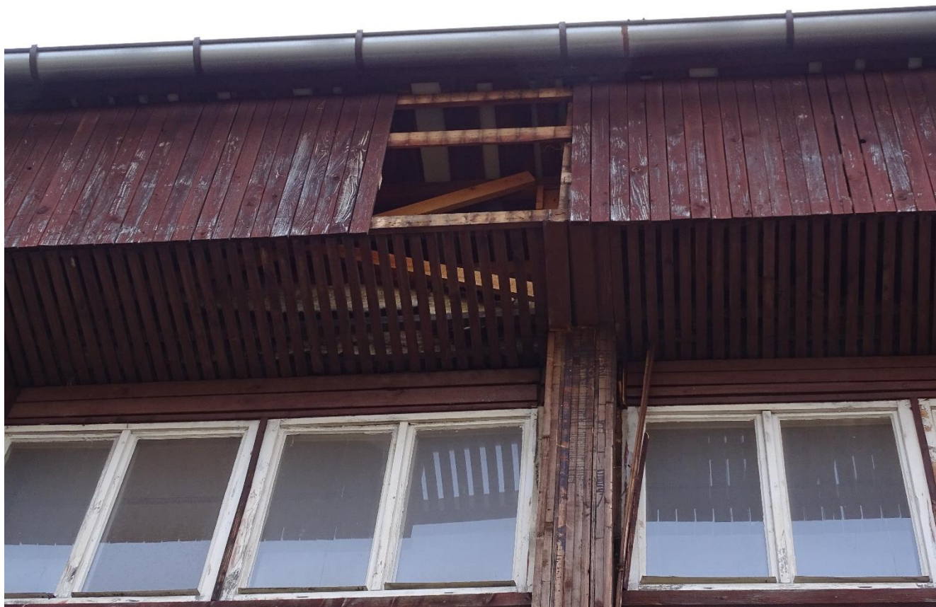
Obr. č.7 – Foto – príprava pre vstup do priestoru medzi väzníkmi
