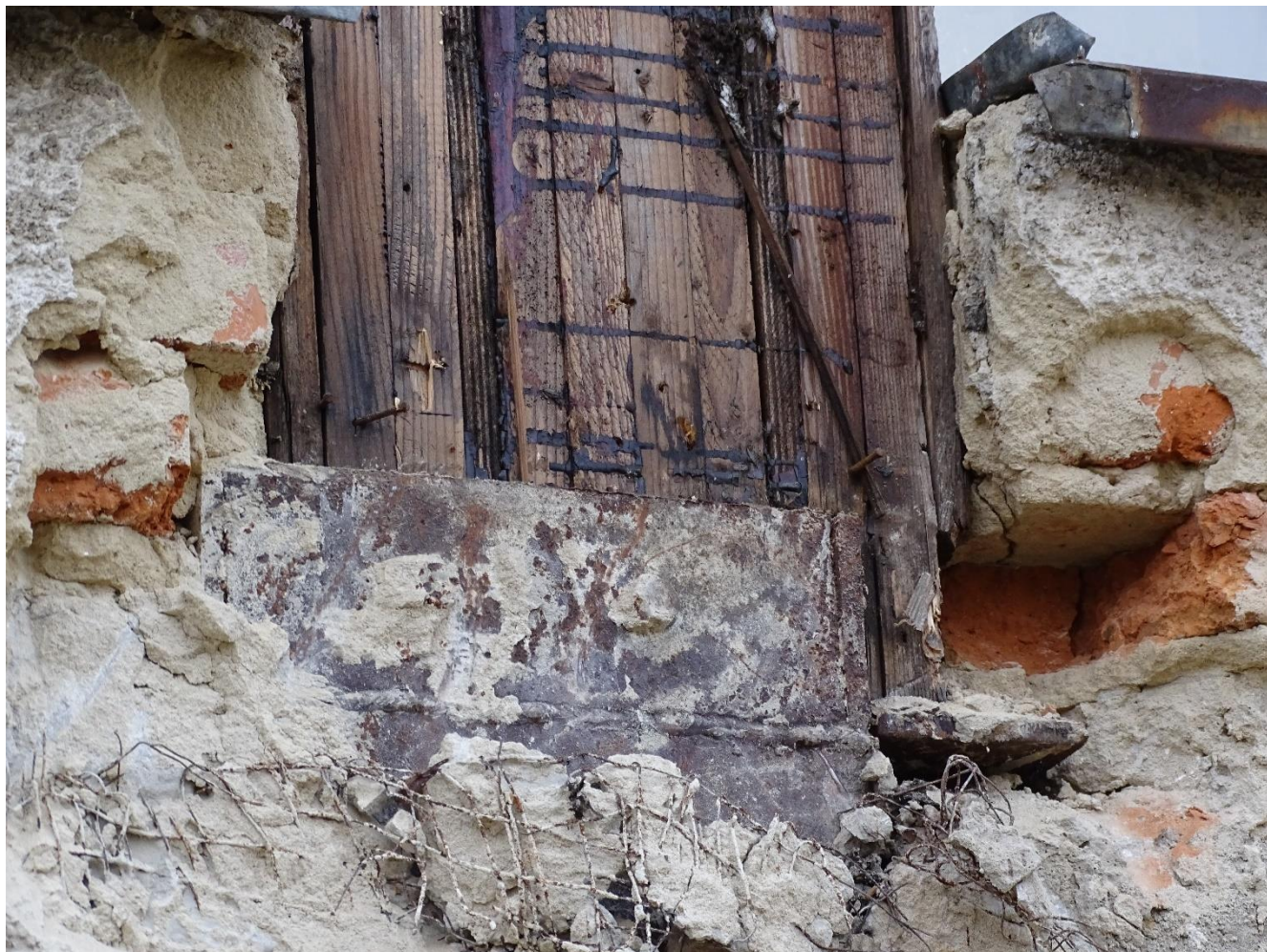
Obr. č.29 – Foto – Detail pätý stĺpa na exteriéri
