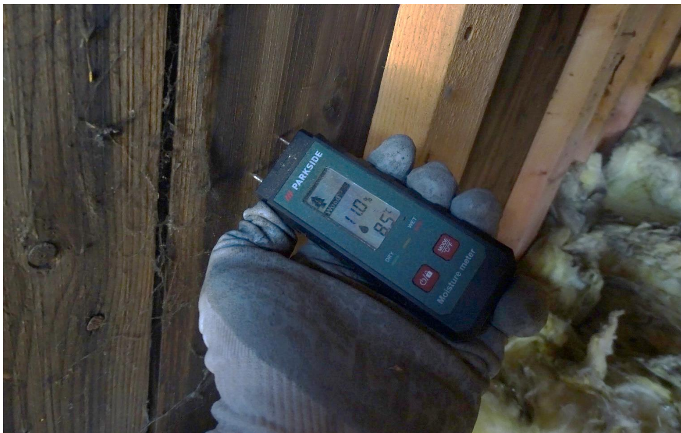
Obr. č.19 – Foto – meranie vlhkosti väzníka vpichovacím vlhkomerom
