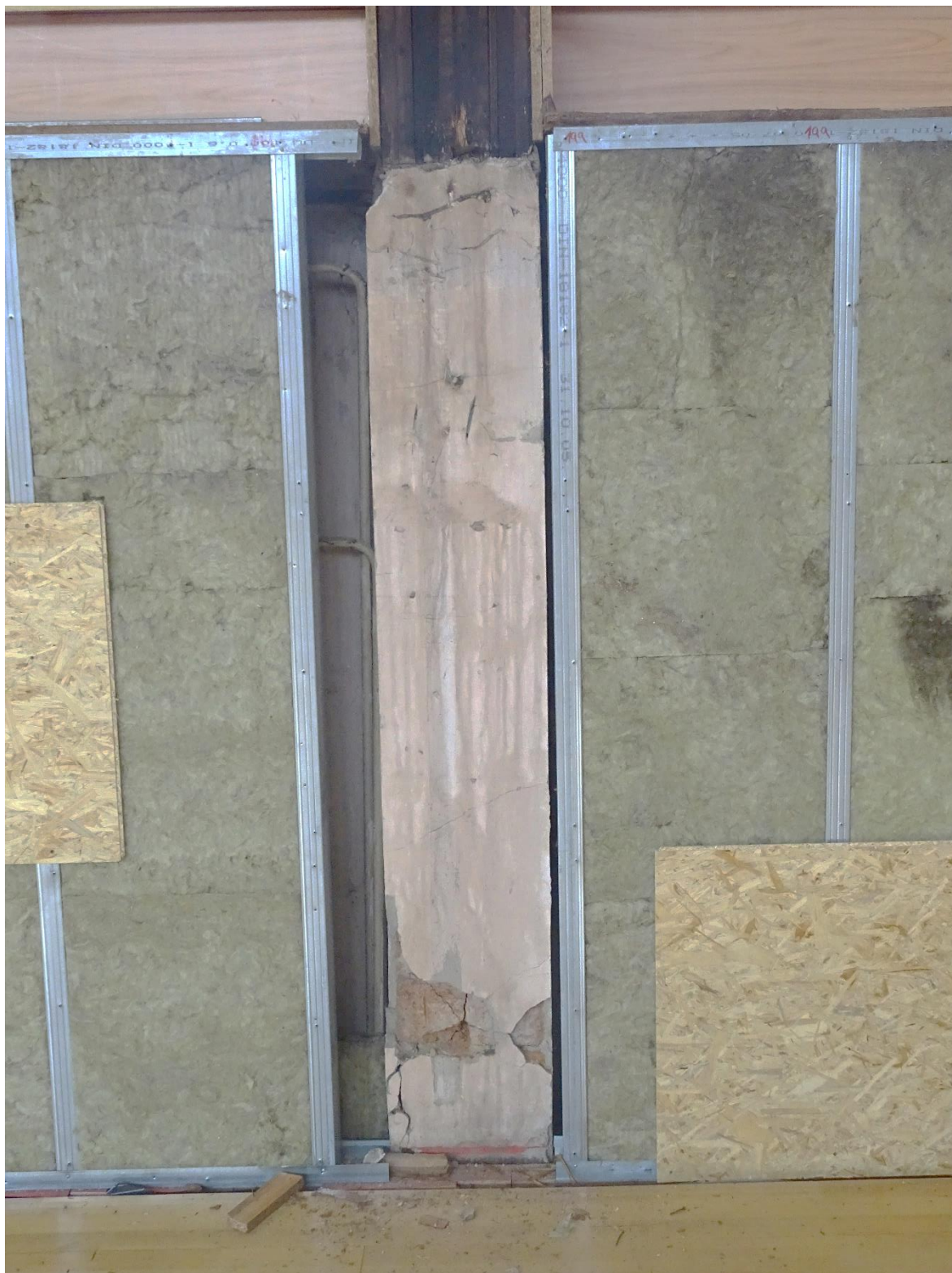
Obr. č.39 – Foto – Murovaný pilierik stĺpa z interiéru
