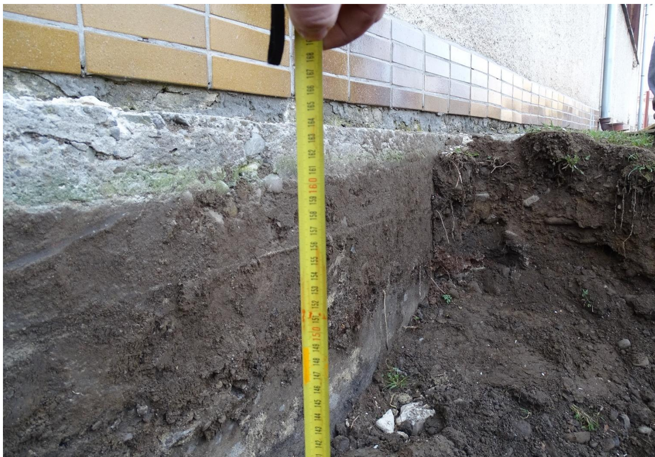
Obr. č.47 – Foto – meranie hĺbky základového pása
