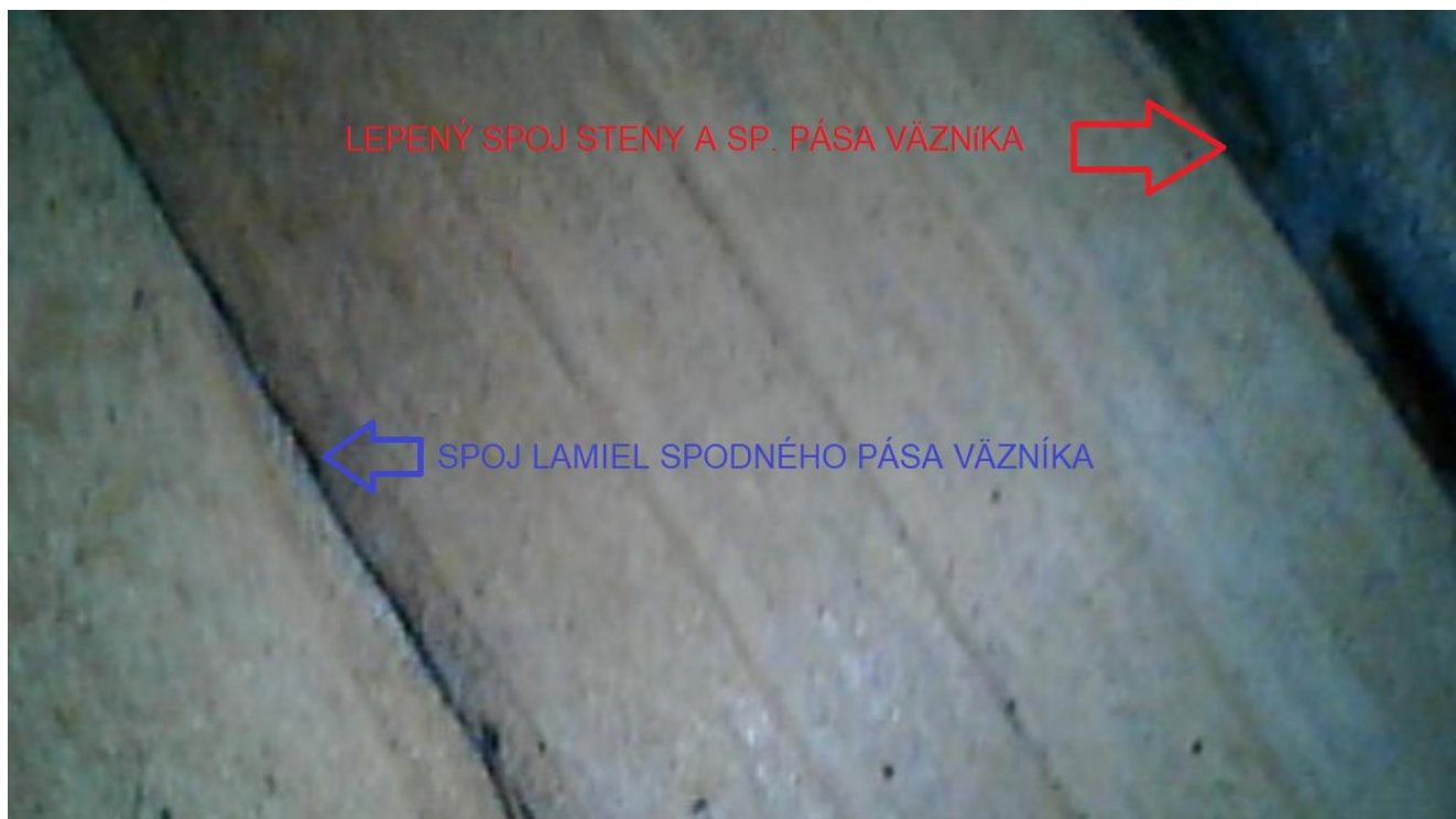
Obr. č.23 – Foto – Endoskopická snímka z vnútornej dutiny vážníka
