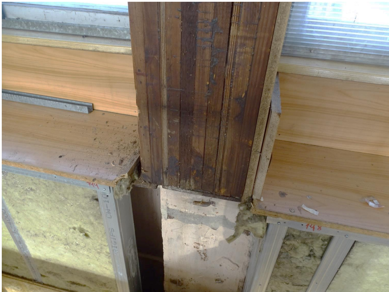
Obr. č.31 – Foto – Detail päty stĺpa v interiéri pohľad čelný
