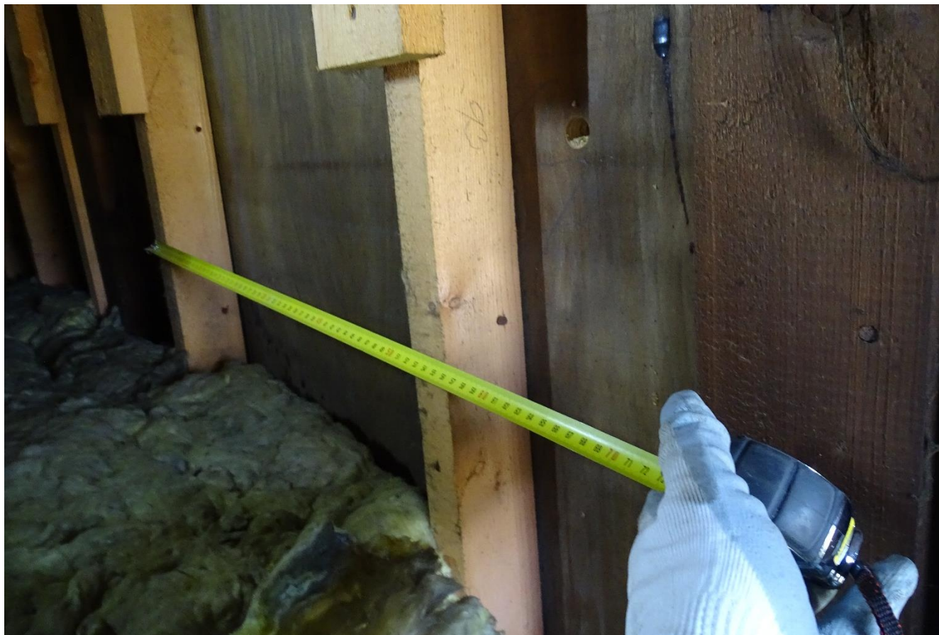
Obr. č.12 – Foto – rozostupy podpier väzníc
