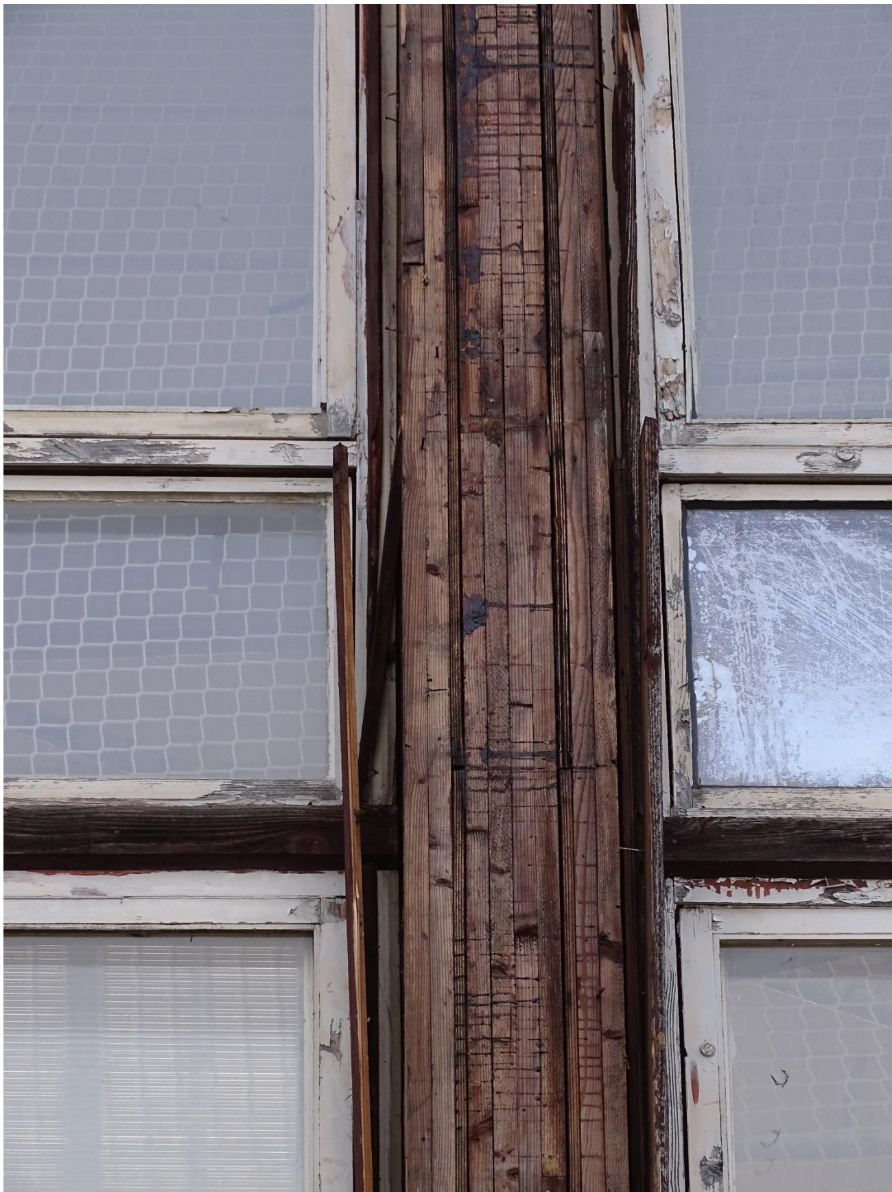
Obr. č.27 – Foto – plocha exteriérovej pásnice stĺpa v stredovej tretine
