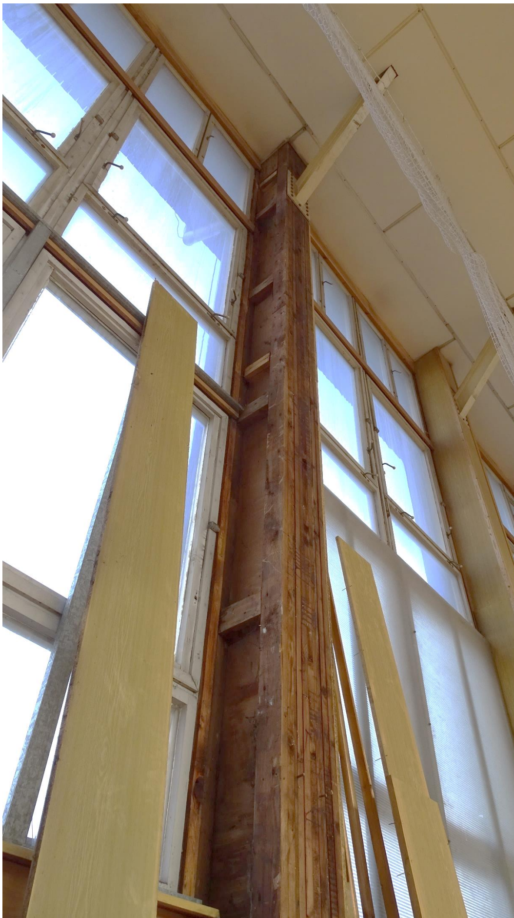
Obr. č.33 – Foto – Pohľad na stĺp v interiéri
