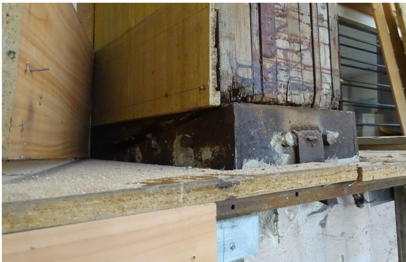
Obr. č.41 – Foto – Kíbové sedlo pre stĺp priečnej väzby na hlave pilierika
