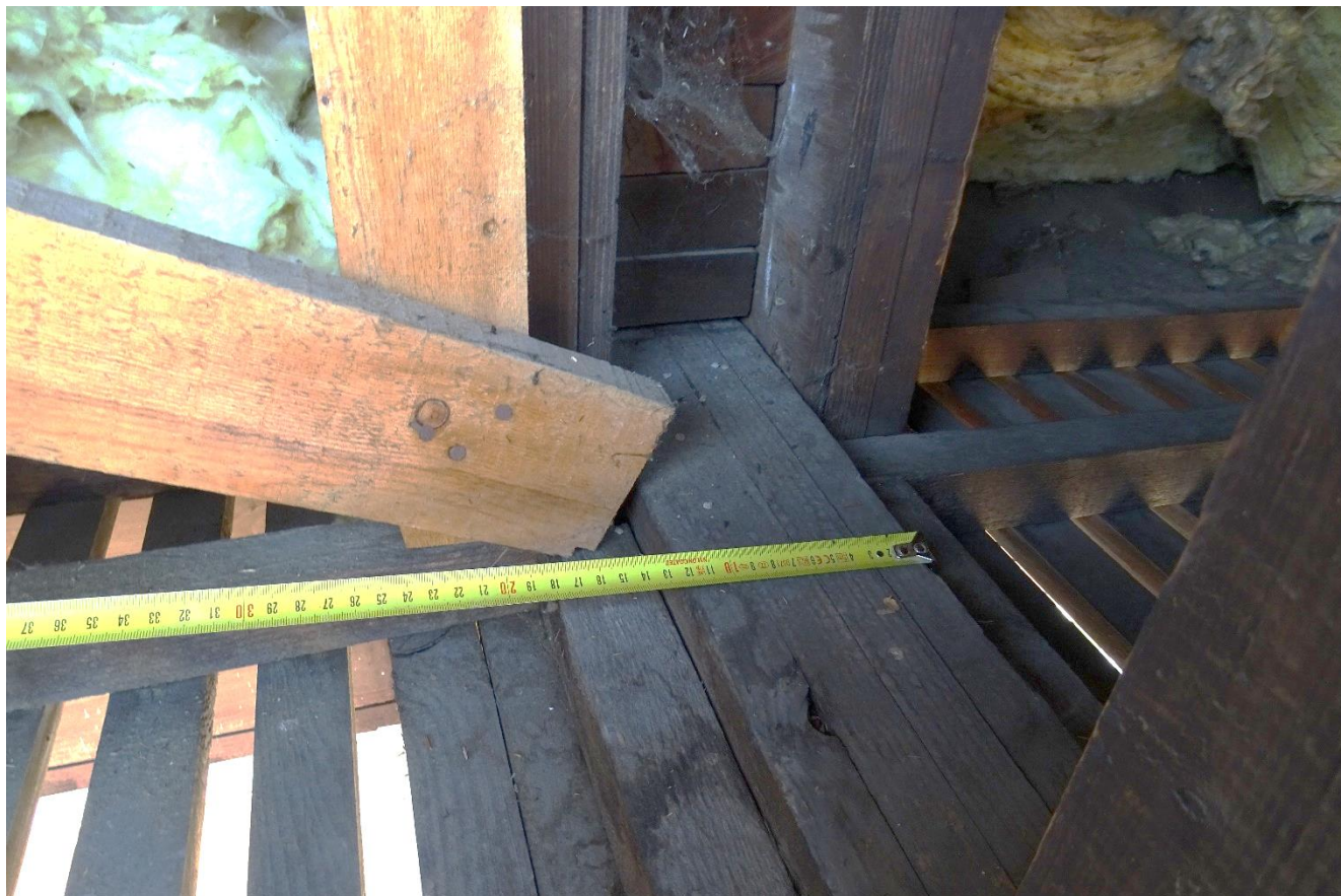
Obr. č.22 – Foto – Koncová úprava vážníka
