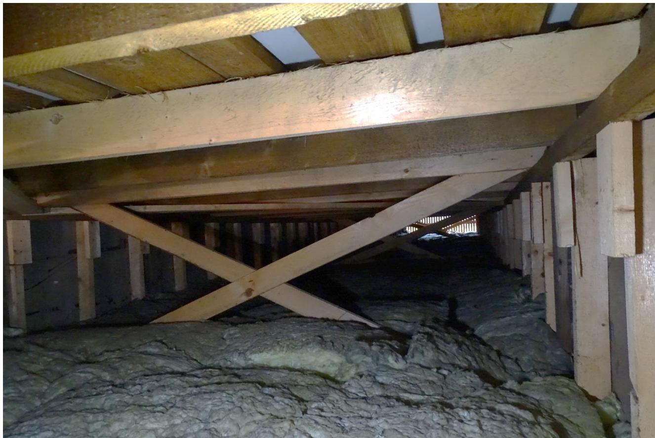
Obr. č.16 – Foto – priečne stuženie medzi väzníkmi
