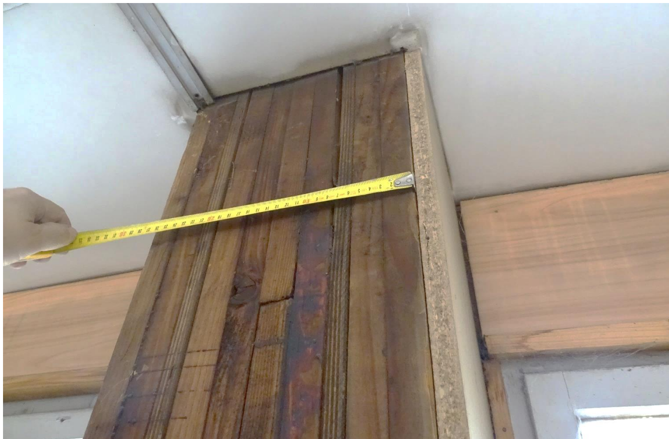
Obr. č.36 – Foto – Pohľad na stĺp v interiéri nad vzperou – pod styčnikom s vážnicou
