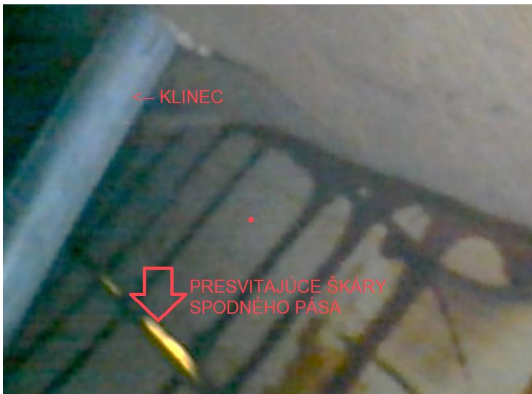
Obr. č.38 – Foto – Endoskopická snímka z vnútornej dutiny stĺpa
