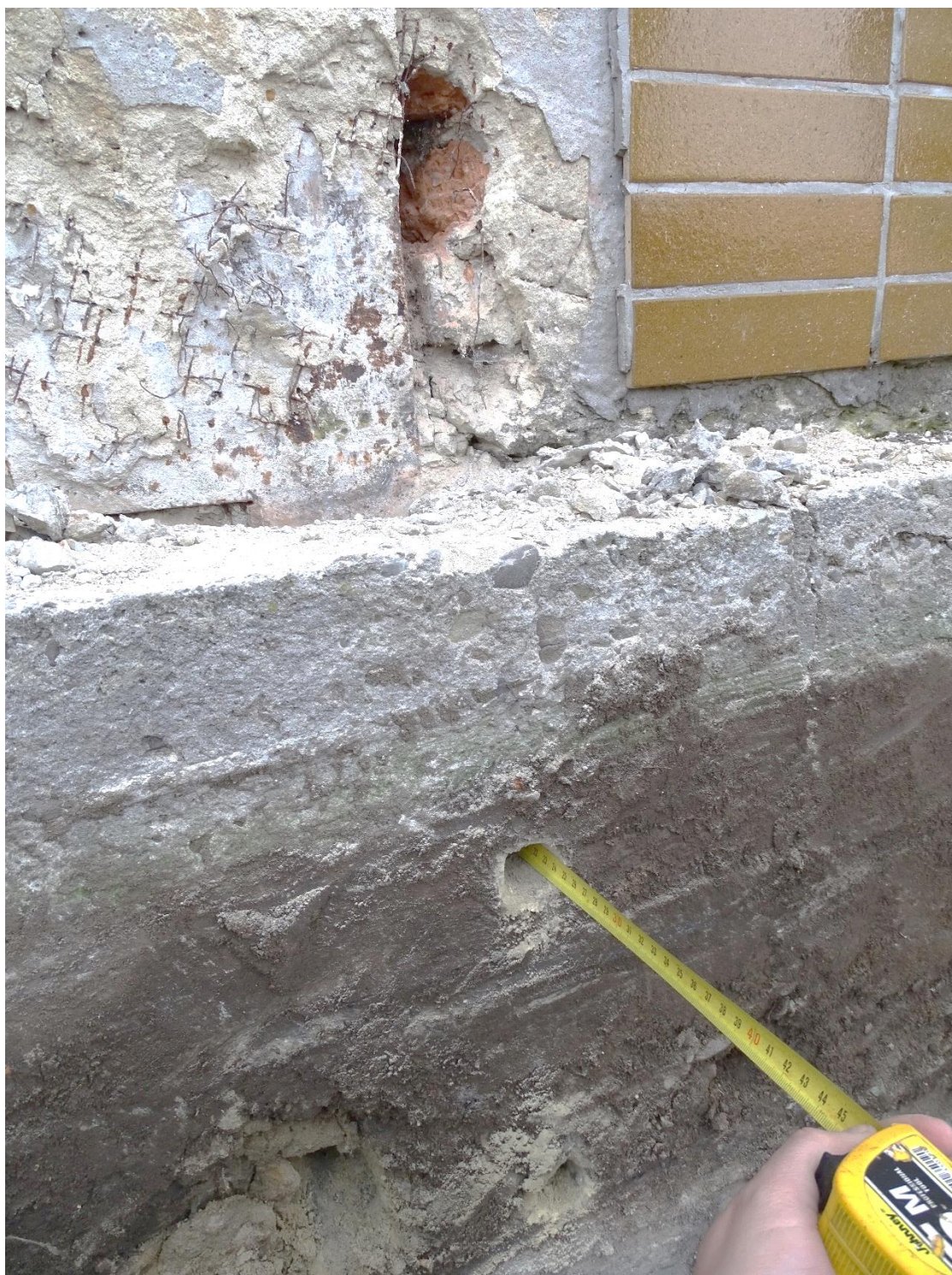
Obr. č.45 – Foto – meranie šírky drieru základového pásu
