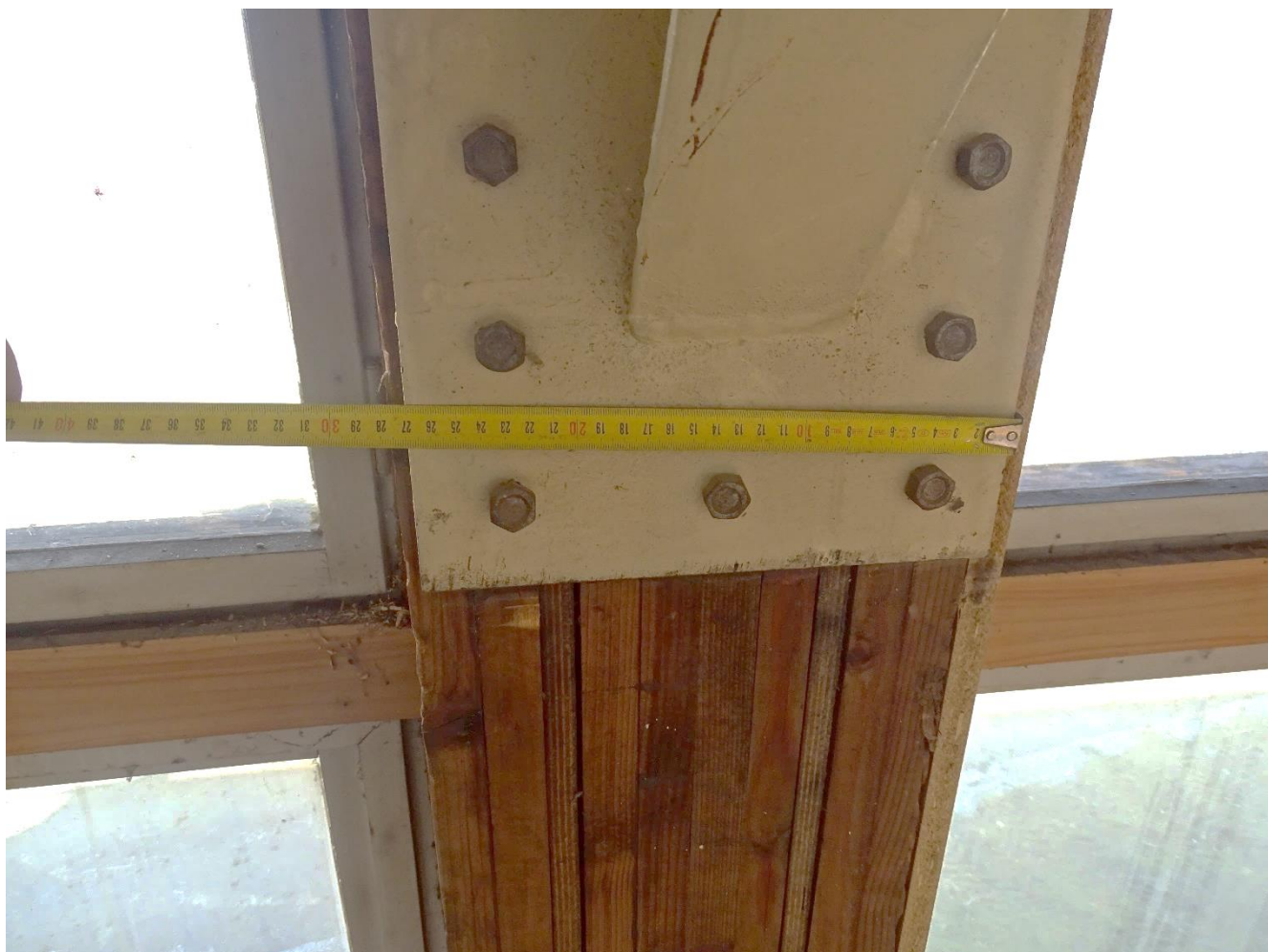
Obr. č.35 – Foto – Pohľad na stĺp v interiéri pri styčniku rohovej vzpery
