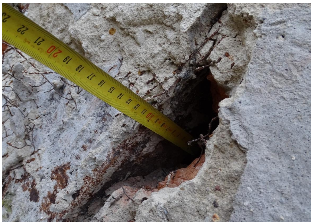
Obr. č.44 – Foto – Zemranie pásnice U č.280
