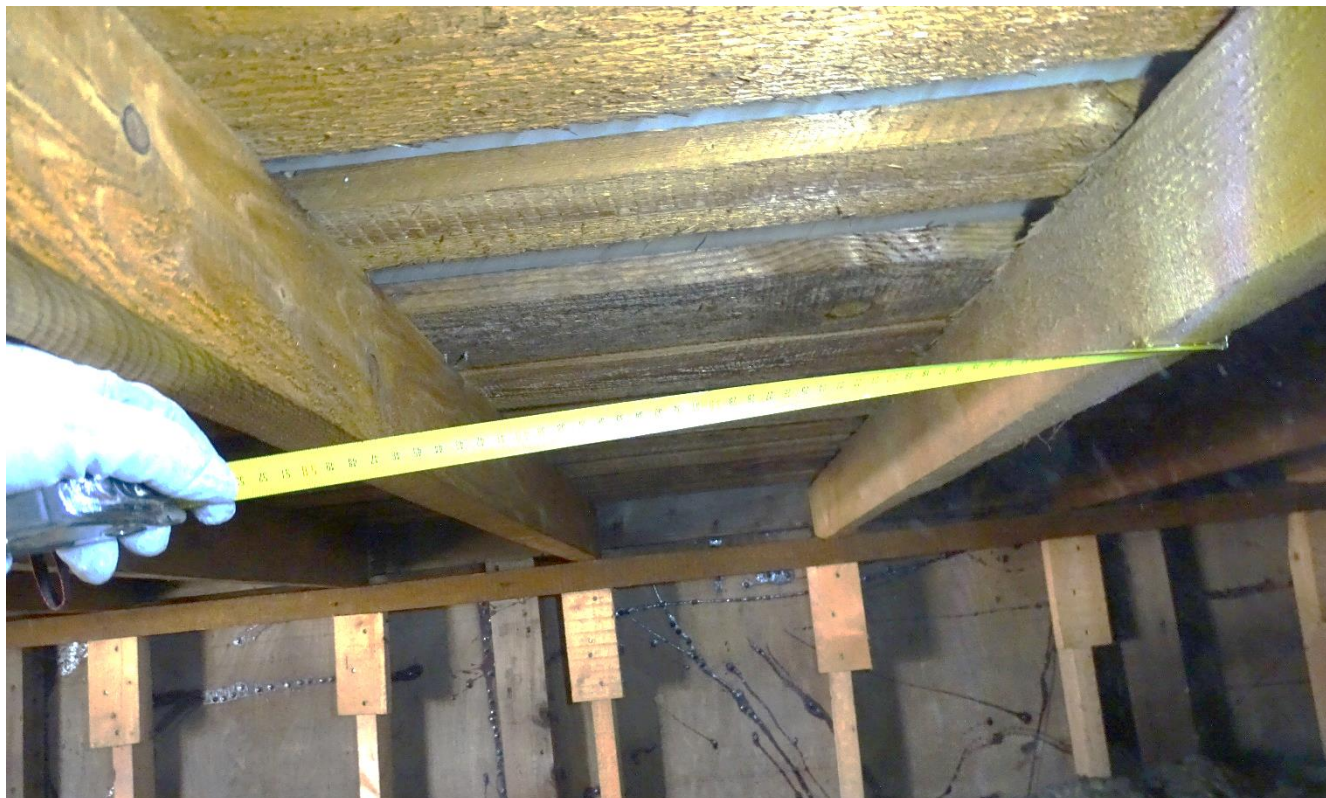
Obr. č. 14 – Foto – rozostupy väzníc
