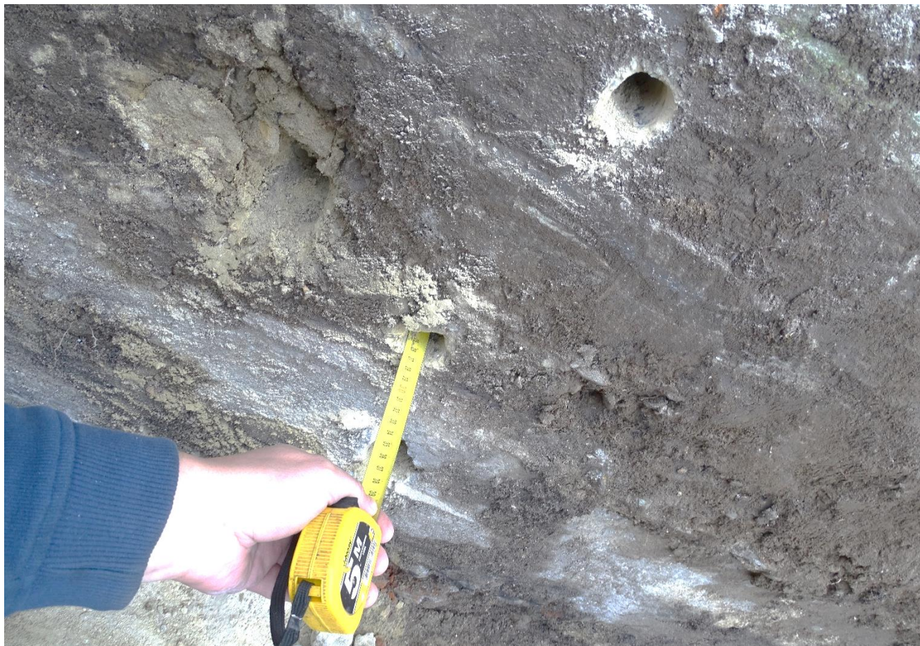
Obr. č.46 – Foto - meranie šírky drieru základového pása
